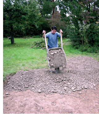
Anlage einer Ruderalfläche: Die Pflanzmulde wird mit Wandkies aufgefüllt.
